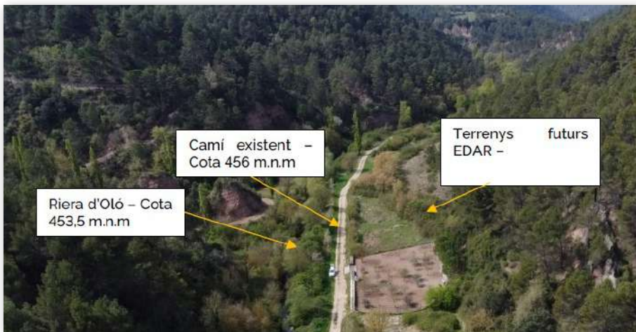
Localització de la futura depuradora. Foto@GoogleMaps
